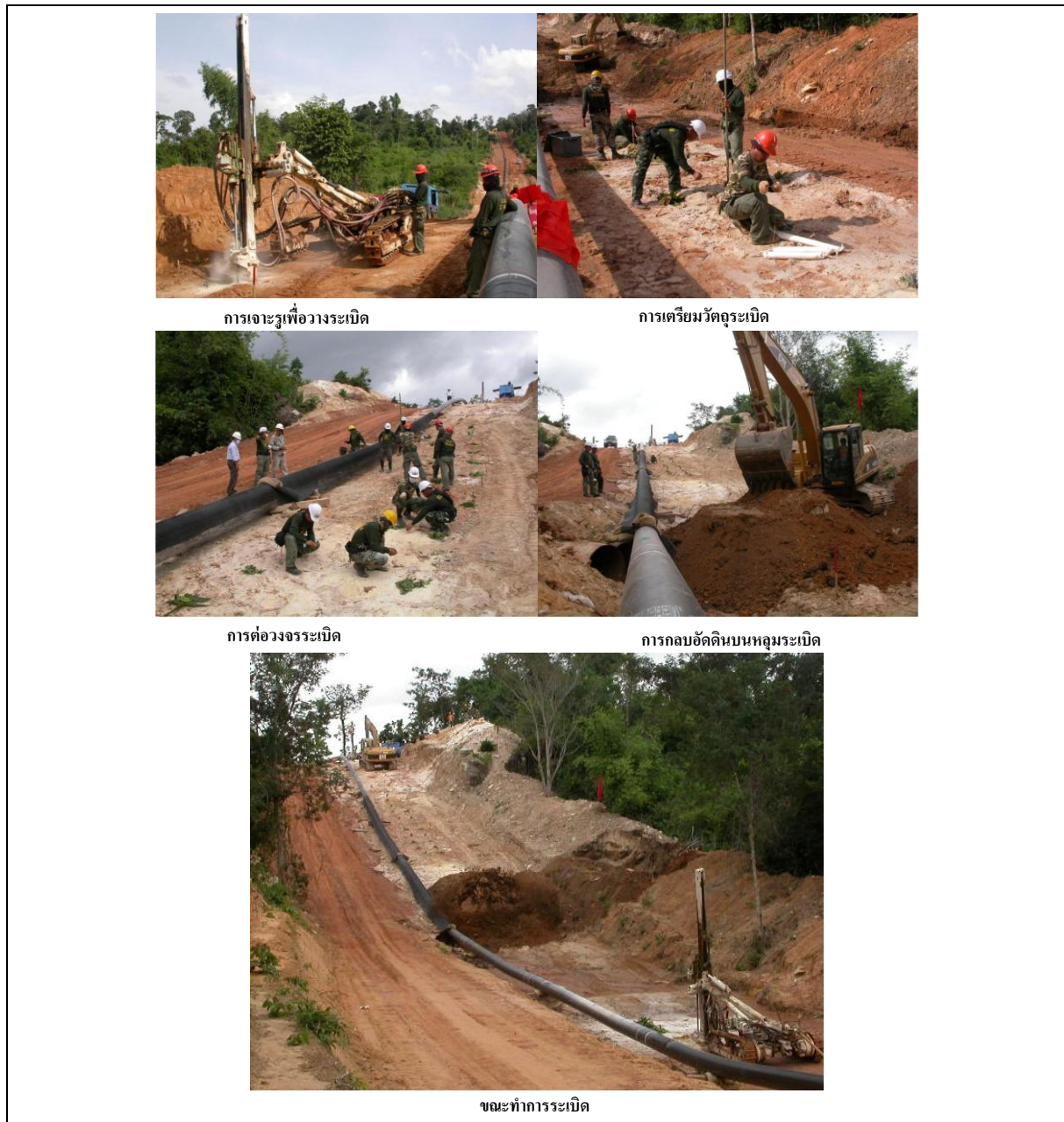
รูปที่ 2.5-6: วิธีการระเบิดเพื่อขุดร่องในการดำเนินงานของ “โครงการระยะที่ 1” ที่ดำเนินการแล้ว
