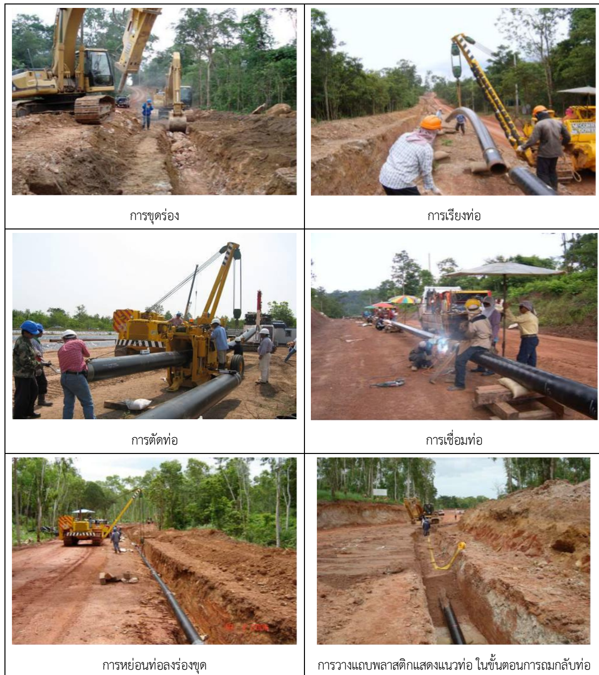
รูปที่ 2.5-7: การวางท่อโดยการขุดเปิด (Open cut) ที่ดำเนินการไปแล้วของ “โครงการระยะที่ 1”
